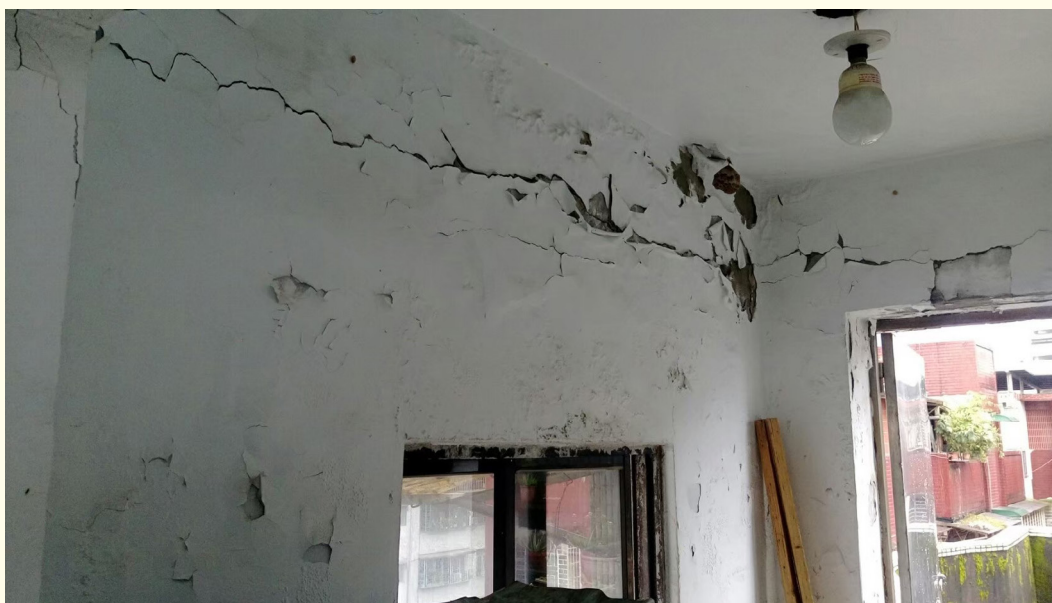
▲更新前海砂屋室內狀況
