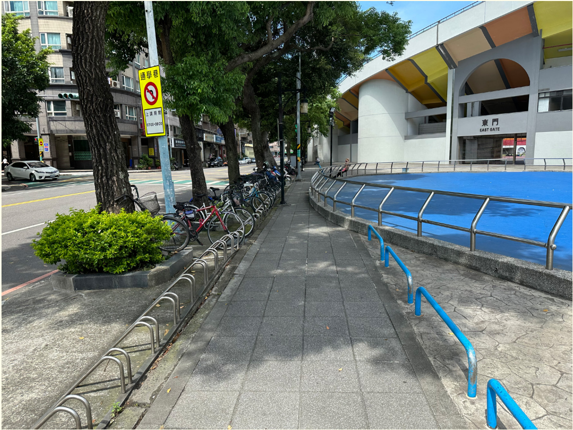
▲ 東門廣場 - 施工前
