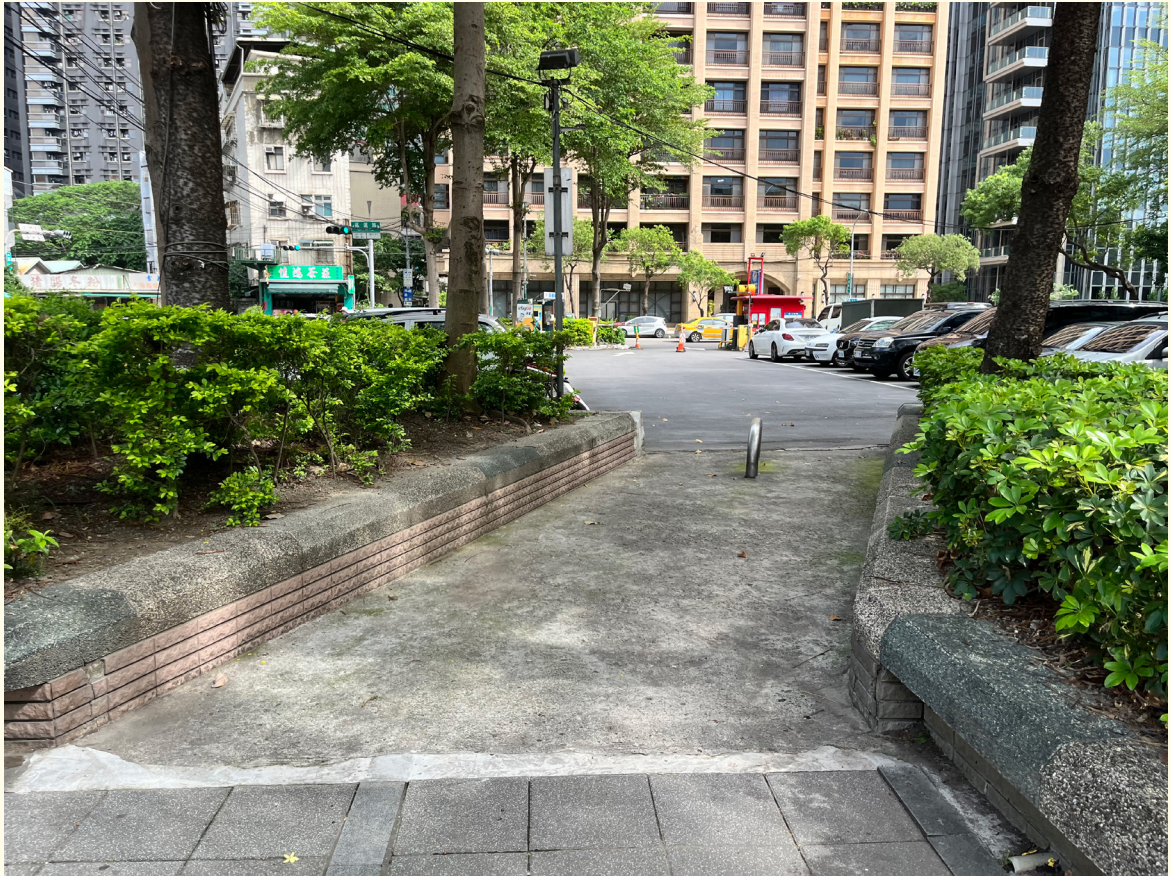
▲西門廣場 - 施工前
