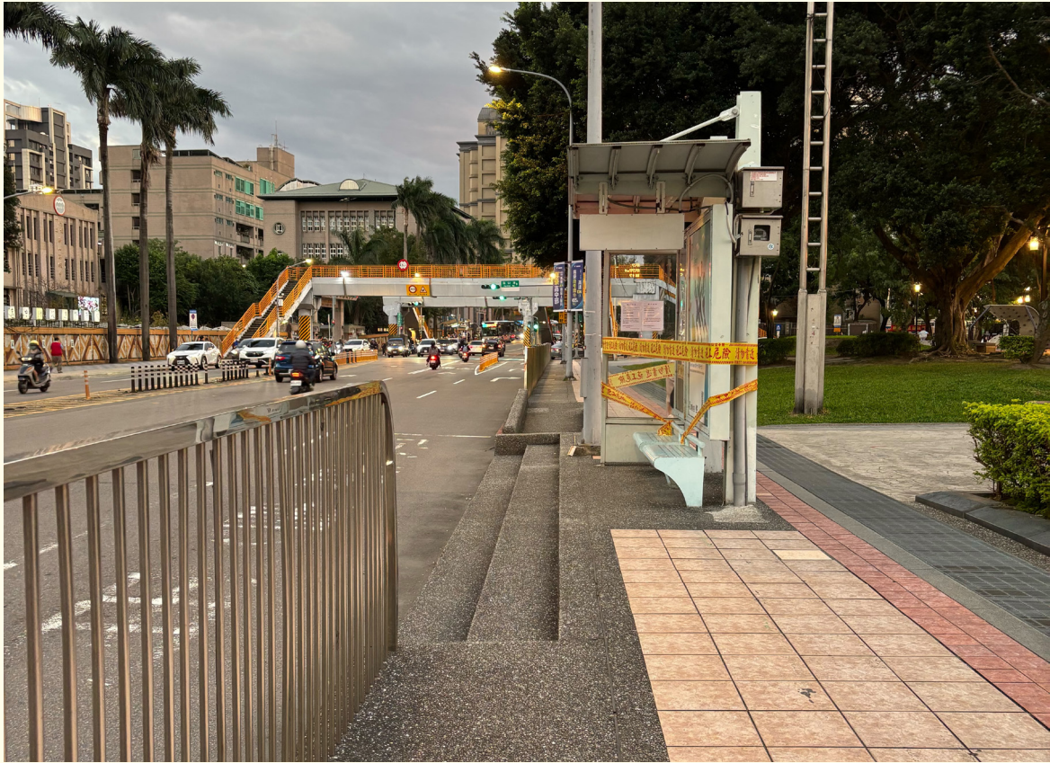
▲ 漢生東路側 - 施工前
