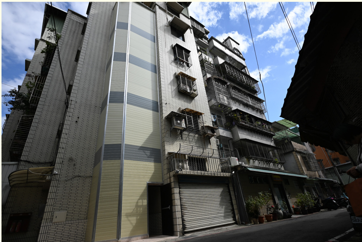
▲ 永和永平路增設電梯後完工照片
