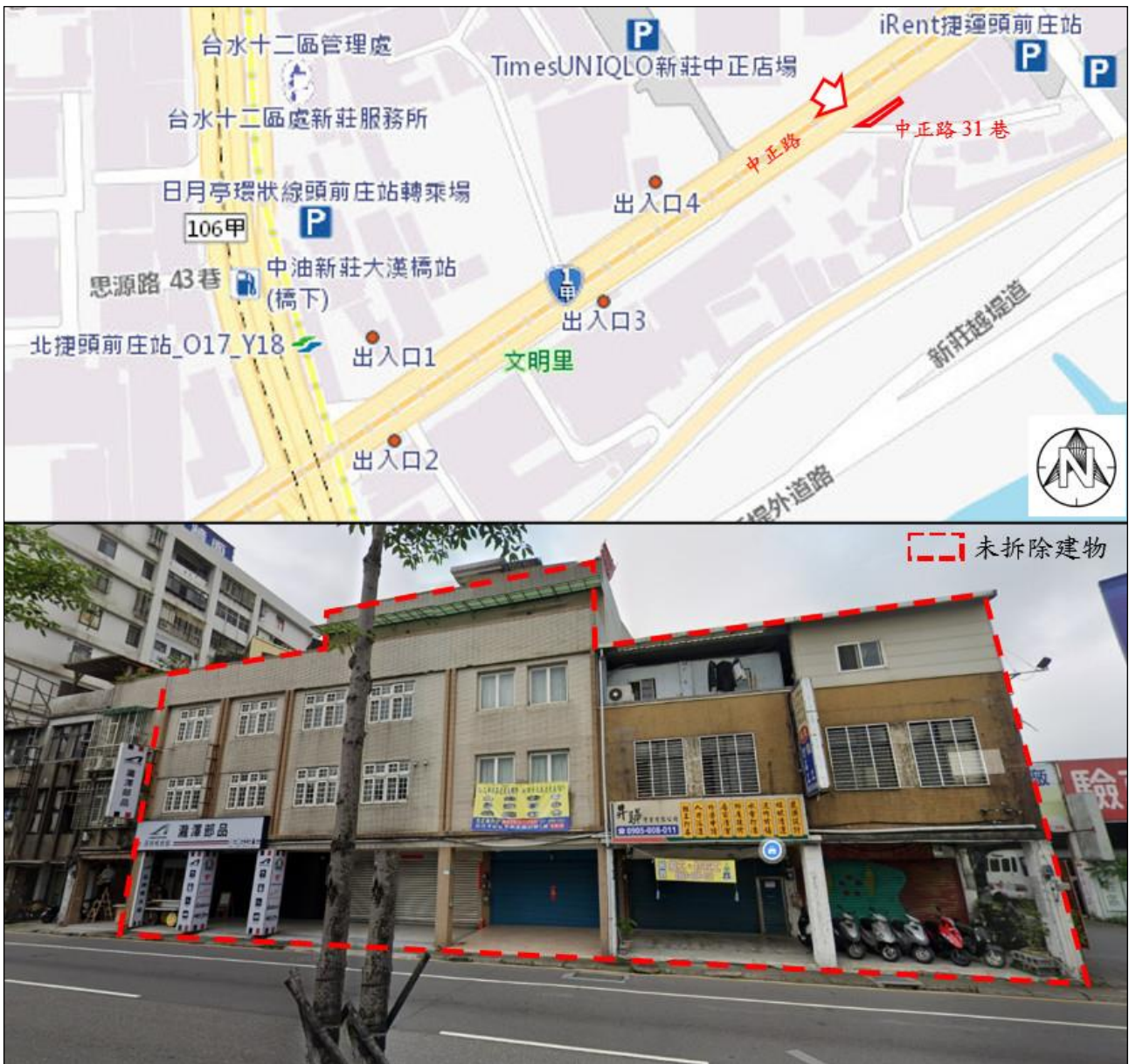
圖 2 未拆除建物之現況
