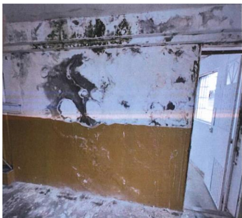
圖13 建物現況照片(3)
