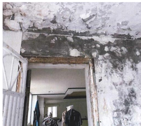
圖14 建物現況照片(4)
