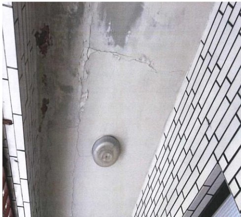
圖11 建物現況照片(1)
