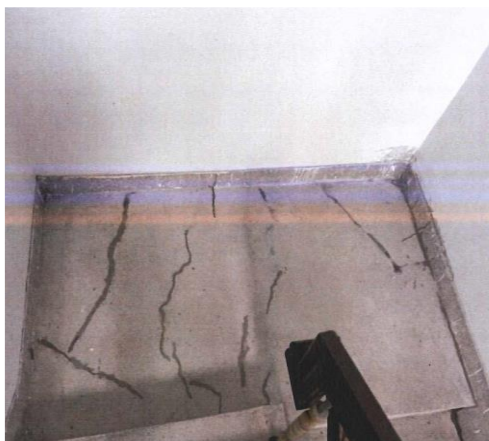
圖15 建物現況照片 (5)
